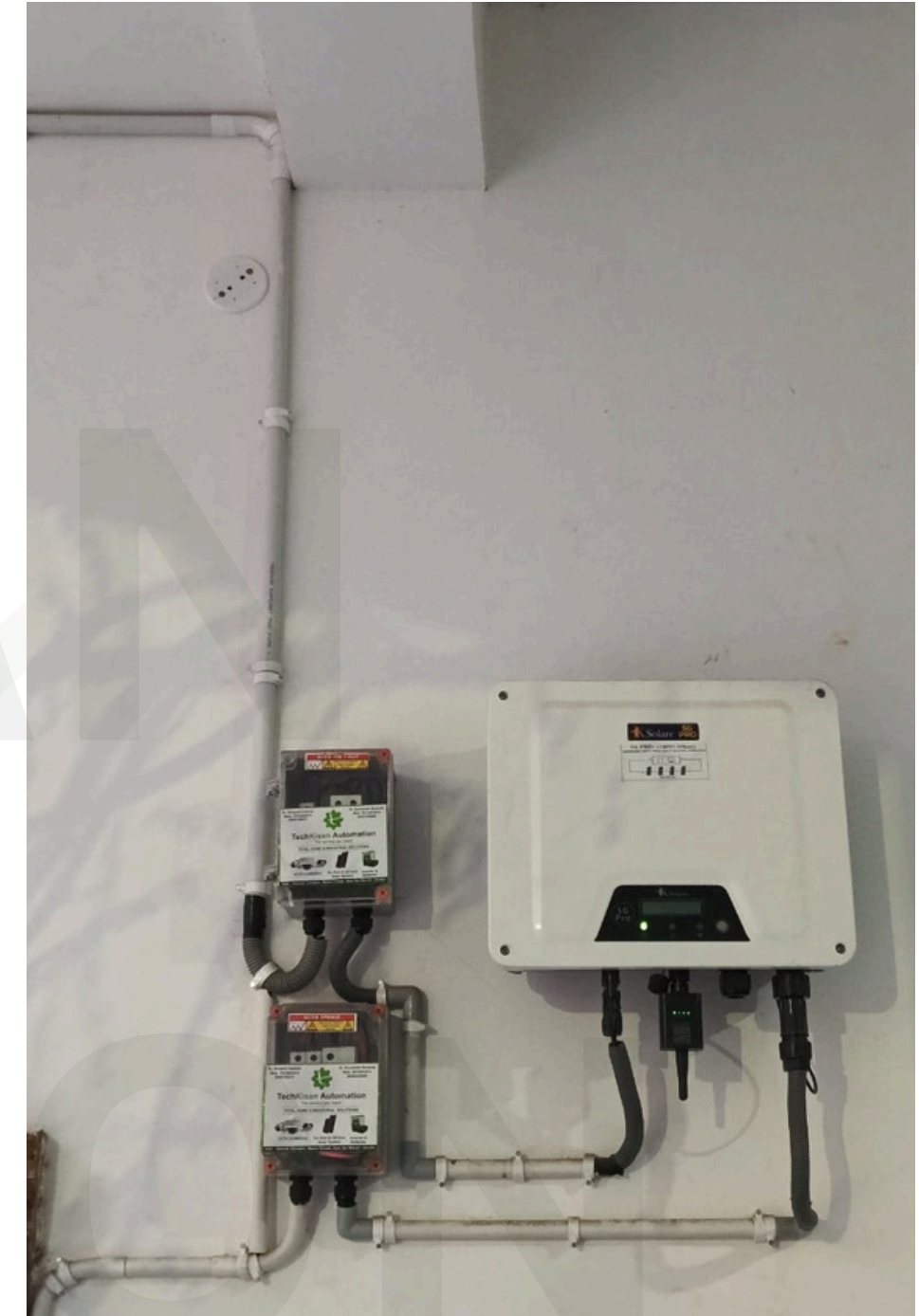
Proper Conduit Installation
